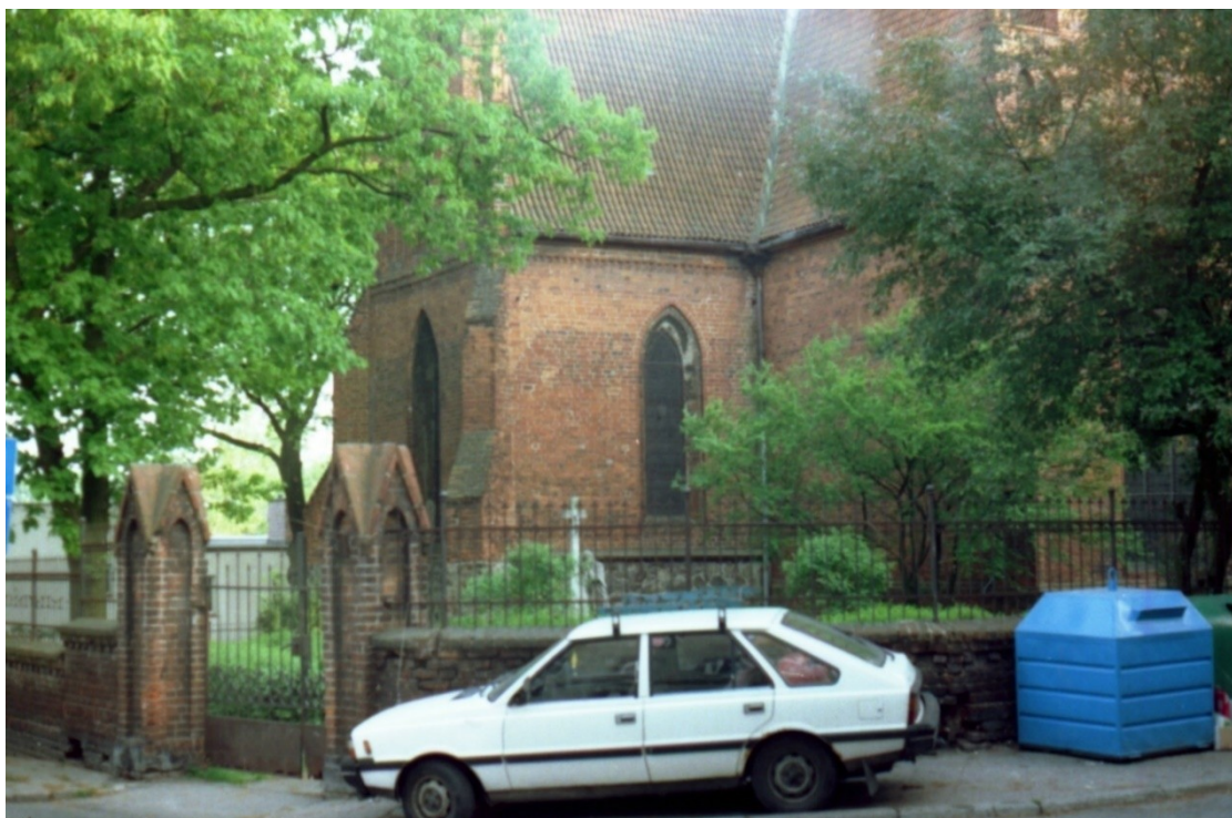
Ryc. 43. Kościół św. Mikołaja w Chełmży, 2007 r. Zdjęcie przedstawia północną ścianę prezbiterium.
