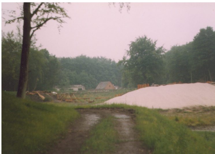
Zamełowo- prace renowacyjne, lato 2004
