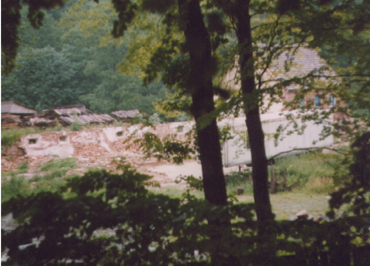
Zamełowo- prace renowacyjne, lato 2004
