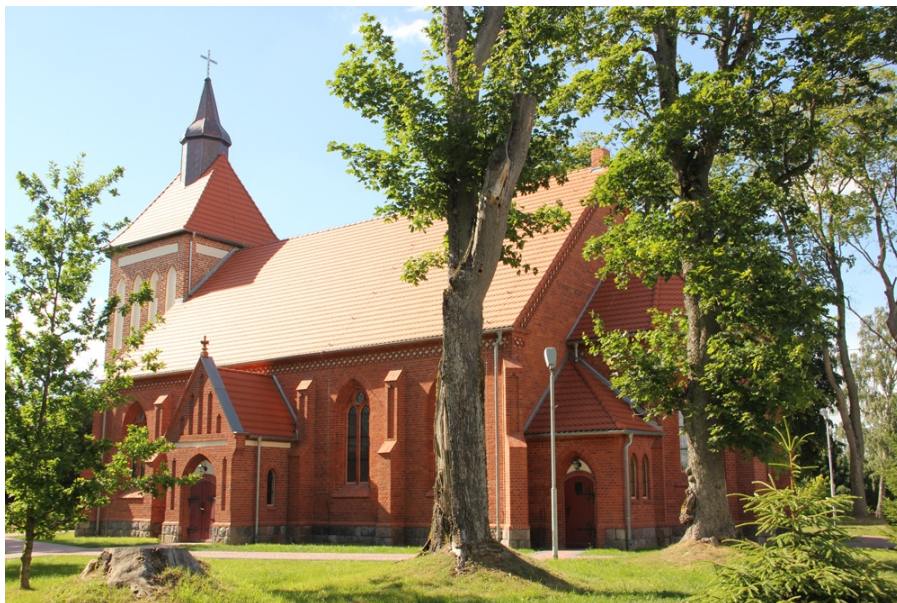
Ryc. 51. Słonowice; kościół p.w. św. Stanisława Kostki, widok od południowego-wschodu. 2024.
