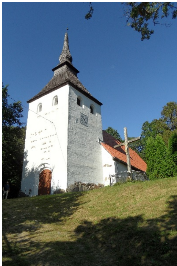
Ryc. 36. Osowo, kościół pw. Najświętszego Serca Pana Jezusa- wieża.
