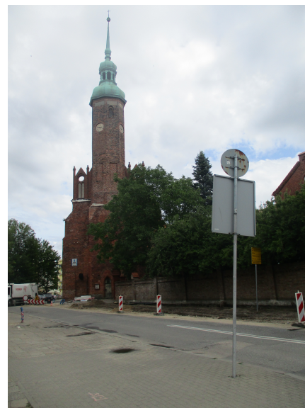
Ryc. 28. Słupsk, kościół pw. św. Jacka, widok od południowo-zachodu, 2019.
