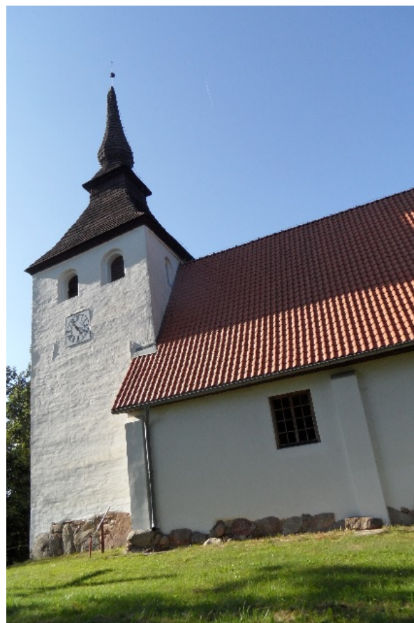
Fot. 40. Osowo, kościół pw. Najświętszego Serca Pana Jezusa- ściana południowa.
