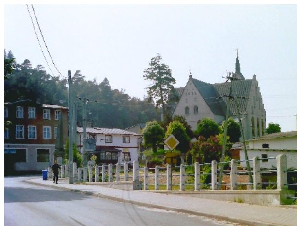
Fot. 42. Kościół u podnóża Rowokołu w Smołdzinie, widziany od północnej strony.
