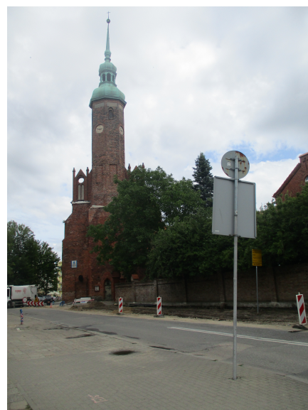
Fot. 10. Słupsk, kościół pw. św. Jacka, widok od południowego- zachodu, 2019.
