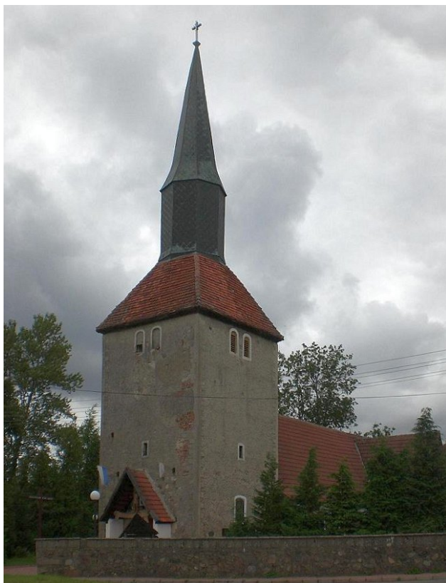
Fot. 23. Dębica Kaszubska, kościół pw. św. Jana Chrzciela. Fot. Gdaniec.
