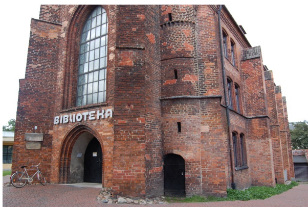
Fot. 5. Słupsk, dawny kościół pw. św. Mikołaja, obecnie biblioteka- wejście, 2007.
