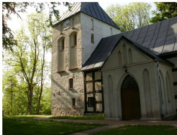
Fot. 61. Wytowno, widok na kościół pw. św. Franciszka z Asyżu, od południowego- wschodu.
