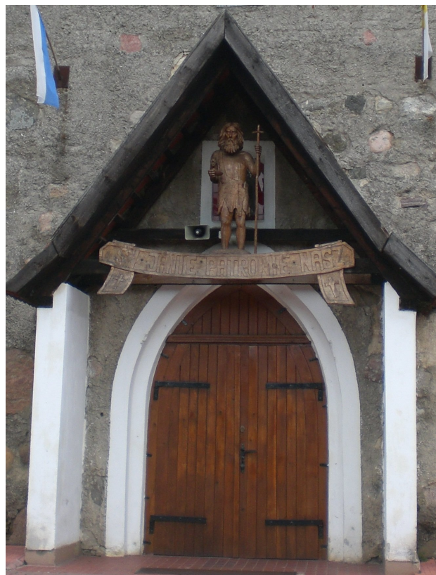
Fot. 24. Dębica Kaszubska, kościół pw. św. Jana Chrzciela. Fot. Gdaniec.
