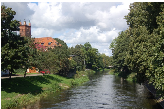
Fot. 3. Słupsk, dawny kościół pw. św. Mikołaja, obecnie biblioteka- przy Słupi, 2007.
