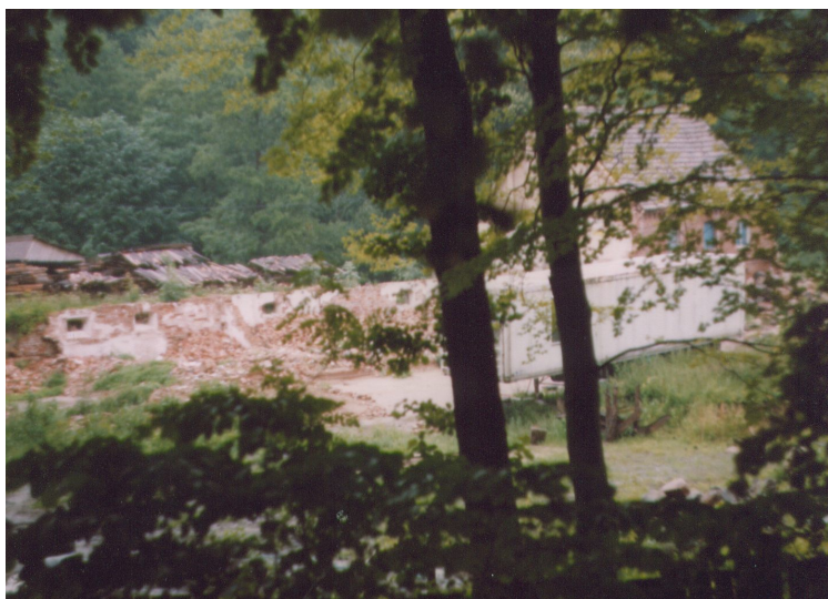
Ryc. 71. Zamełowo- prace renowacyjne, lato 2004
