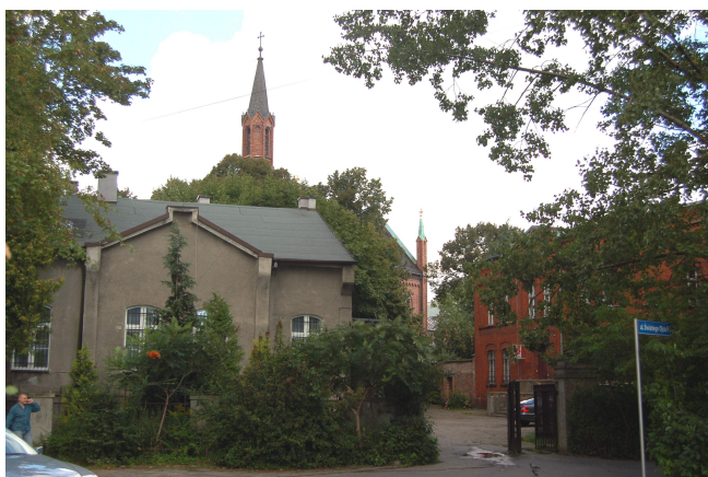
Ryc. 61. Wejście do kościoła od strony ul. Kościelnej
