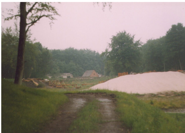
Ryc. 70. Zamełowo- prace renowacyjne, lato 2004
