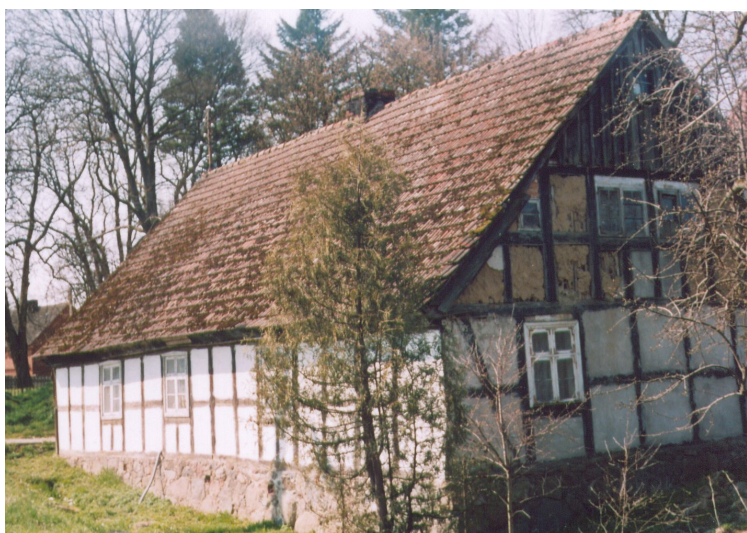
Ryc. 77. Duninowo, dom mieszkalny, lato 2004
