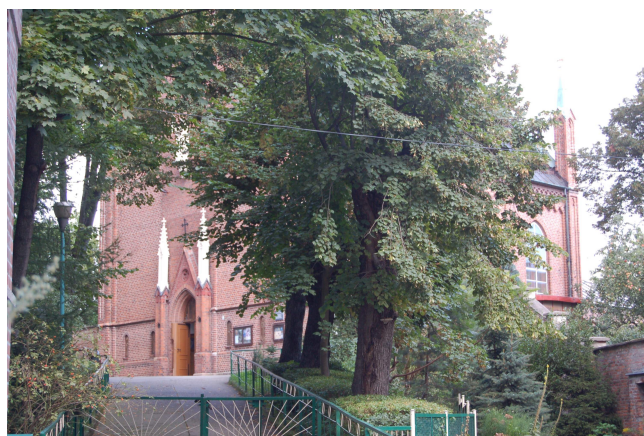
Ryc. 62. Bramka i wejście do kościoła od strony ul. Kościelnej
