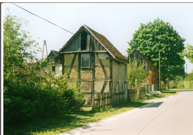
Fot. 5 Droga w Charnowie (wjazd do Charnowa), 2005
