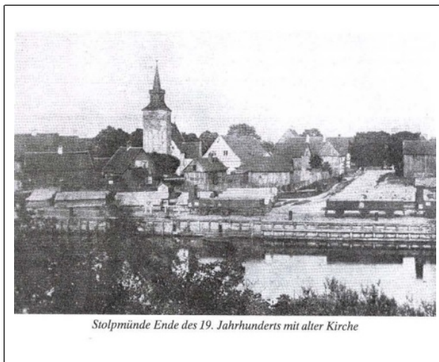
Ryc. 1. Ustka, kościół drewniany pw. św. Jana Chrzciciela i św. Mikołaja, fotografia z końca XIX w. (kościół rozebrany w 1889r.). Skan starej widokówki- prywatna kolekcja. Źródło: Stolper Heimatkreise e.V. Stolpmünde, S. 952. stolp.de/stolpmuende_literatur.html
