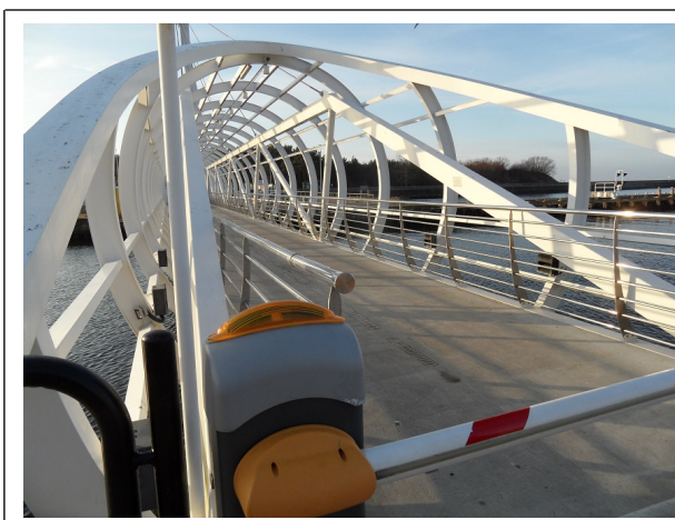
Ryc. 47. Kładka dla pieszych nad Słupią.
